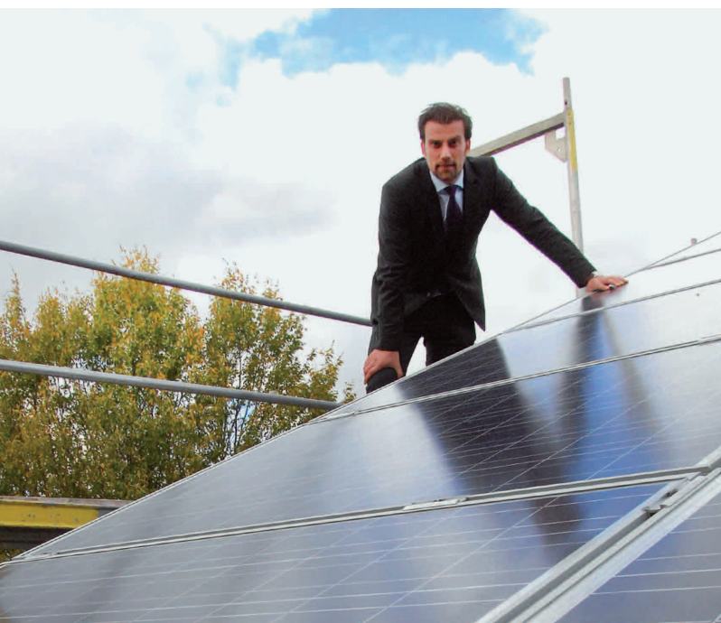
▲ Strom durch Sonnenlicht: Tino Menge von der Neusser Bauverein AG am Standort der Photovoltaik-Anlage Dyckhofstraße.
